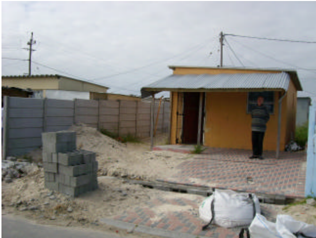
Rolfs kleines Haus, das jetzt erweitert wird
